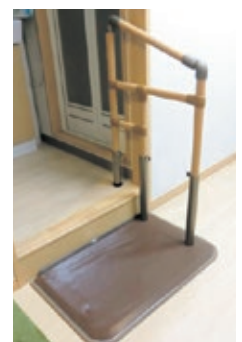
片手すり設置例
