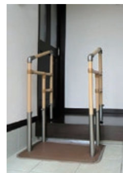
両手すり設置例
